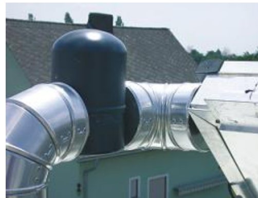
Abbildung 27: Anordnung eines temperaturbeständigen manuellen Entlüftungstopfes mit entsprechendem Wärme- und Witterungsschutz
