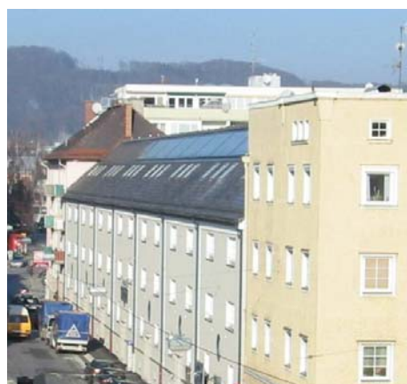
Abbildung 21: Im Zuge einer umfassenden Modernisierung wurde in der Salzburger Plainstraße (42 Wohneinheiten) vom Wohnbauträger gswb eine Solaranlage mit 164 m 2 Kollektorfläche in Verbindung mit einem Wärmeversorgungskonzept nach dem Prinzip von „Zwei-Leiter-Netzen“ und Wohnungsstationen umgesetzt (Bildquelle: gswb)
