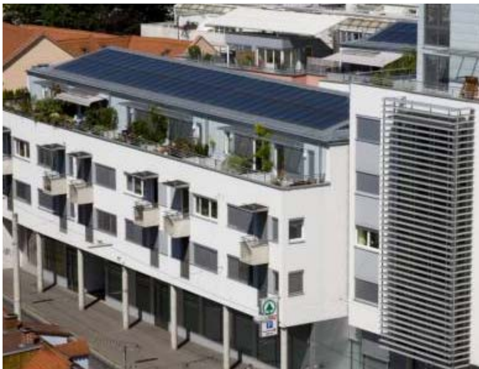
Abbildung 2: Solarwärmeanlagen haben sich als Standard im Neubau von Geschößwohnbauten etabliert (Bildquelle: ENW, Graz).
