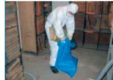
Bild 7: Beispiel für mittlere Sporenexposition (Gefährdungsklasse 1 oder 2, je nach Dauer der Tätigkeit) beim Verpacken von mit Schimmelpilzen kontaminiertem Archivgut, das zuvor oberflächlich abgesaugt wurde
