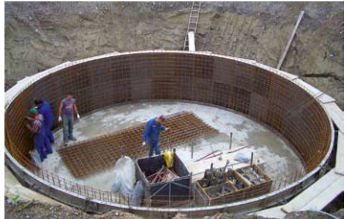
■ Bild 3: Der „SolarEis-Speichers“ übernimmt die Aufgabe eines Kältespeichers für den Sommer und soll im Winter ausreichend viel Wärme der Wärmepumpe zur Verfügung stellen. Kann der Speicher aus bautechnischen Gründen nicht entsprechend groß realisiert werden, oder wird nur wenig Kälte im Sommer benötigt, lässt sich das Speichervolumen durch die Kombination mit einem um den Speicher angebrachten Erdkollektor reduzieren. Auf diese Weise erhält man eine Kombination aus geothermischer Anlage und Latentwärmespeicher auf Wasserbasis.
