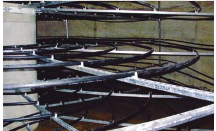
■ Bilder 4 bis 8: Auszug aus der Bauphase des Eisspeichers (von oben nach unten): Verlegung der unteren, äußeren Wärmetauscher; Betonierung des Speichers; Verlegung der äußeren Wärmetauscher. Das untere Bild zeigt einen Blick ins Innere des Speichers.
